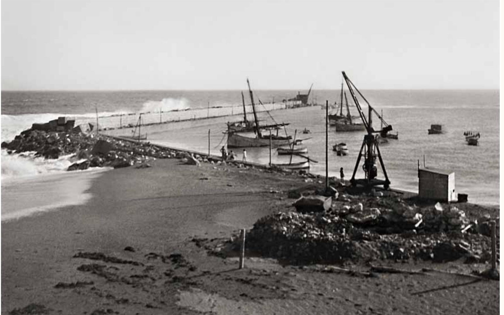
**Construcción del puerto. Grúas colocando bloques de hormigón en el pantalán de levante.**
