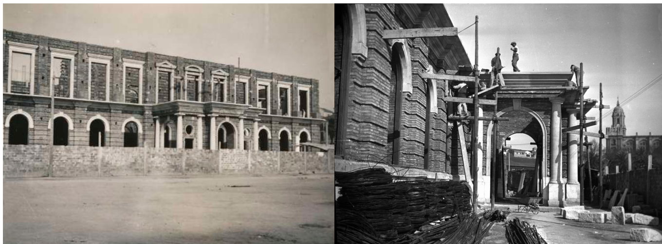
Edificio de la Autoridad Portuaria en construcción. Archivo de la Autoridad Portuaria.
